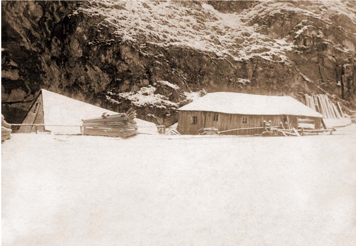
Les installations industrielles de Bonport, moulin et scierie, soulevées par les eaux lors des inondations de janvier 1883. Les bâtiments furent démolis peu après pour n'être plus jamais reconstruits. C'était la fin définitive du Bonport industriel.
